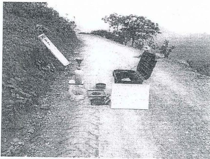
FIGURA 29. Ensayo de Densidad de Suelo en Campo KM 07+000 (Método del cono de arena).
